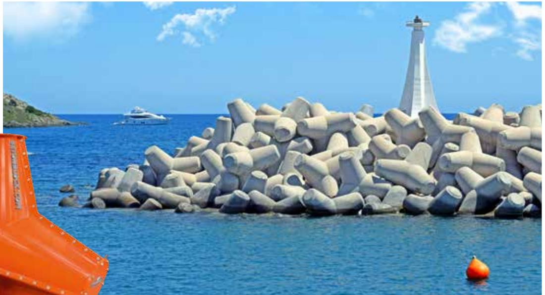
Im küsteningenieurwesen ist ein tetrapod eine betonkonstruktion, die als panzerungseinheit in wellenbrechern verwendet wird.
