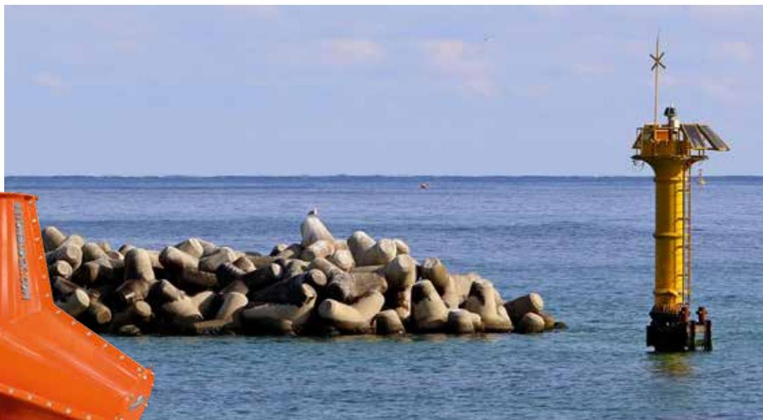
En la ingeniería costera, un tetrapodo es una estructura de hormigón utilizada como unidad de contención en rompeolas.
