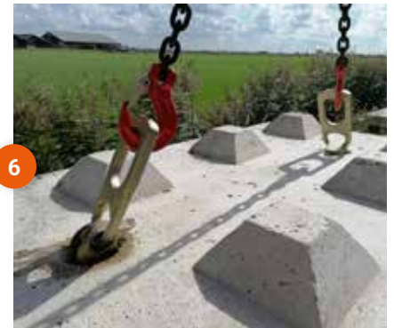
6 Fije los ganchos a los anclajes y la carga está lista para ser levantada
