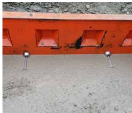
3 El anclaje está fundido en su totalidad, tenga cuidado con la vibración del hormigón
