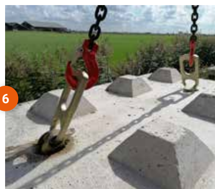
Fixez les crochets aux ancrages et la charge est prête à être levée
