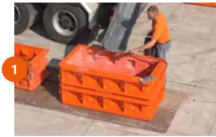
1 Placer moule sur une plaque d'acier
