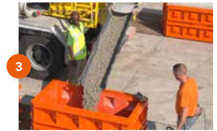
3 Coulage du béton
