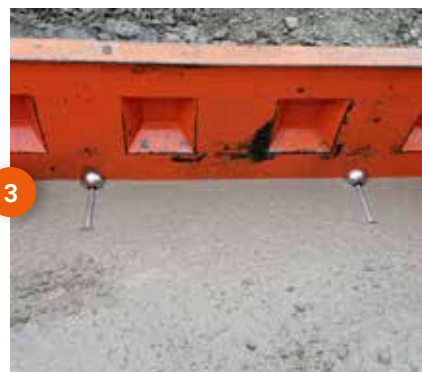
L'ancre est coulée dans son intégralité, attention à faire vibrer le béton
