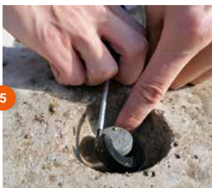
Retirez le caoutchouc de l'ancre
