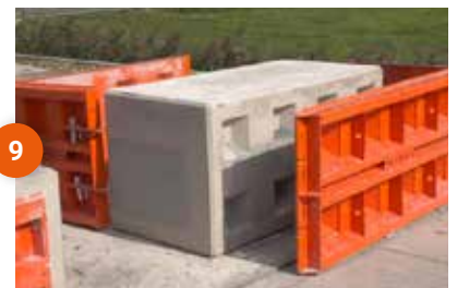
9 Blocco di calcestruzzo pronto
