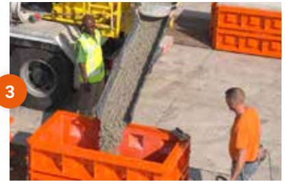
3 Gettata di calcestruzzo
