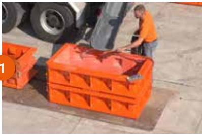
1 Posizionamento dello stampo su una piastra di acciaio
