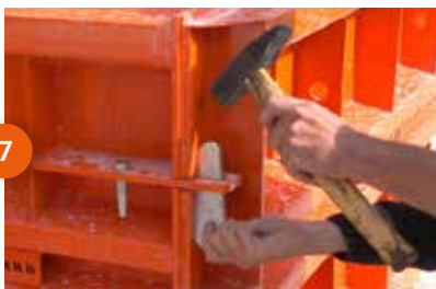
7 Rimozione di perni e cunei
