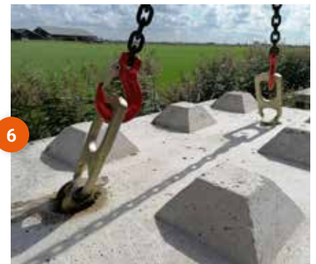
6 Fissare i ganci agli ancoraggi e il carico è pronto per essere sollevato
